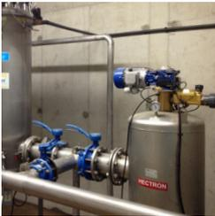
**Forages, géothermie.** Ces filtres apportent une solution efficace pour la filtration des eaux de forages (géothermie, irrigation,...), même en présence d'argile ou de boues fines.
